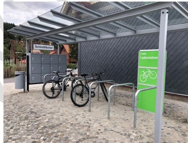
Abbildung 8 Beispiel einer Fahrradabstellanlage mit Ladestation und Schließfächern an einem Bahnhof
